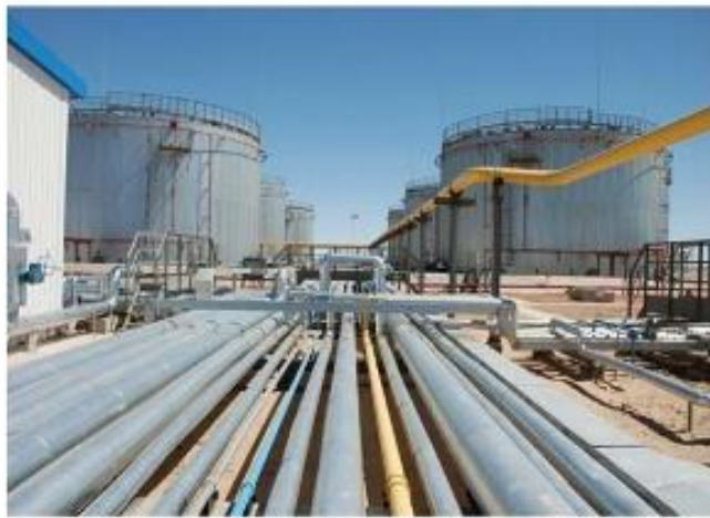
石油管道巡检
